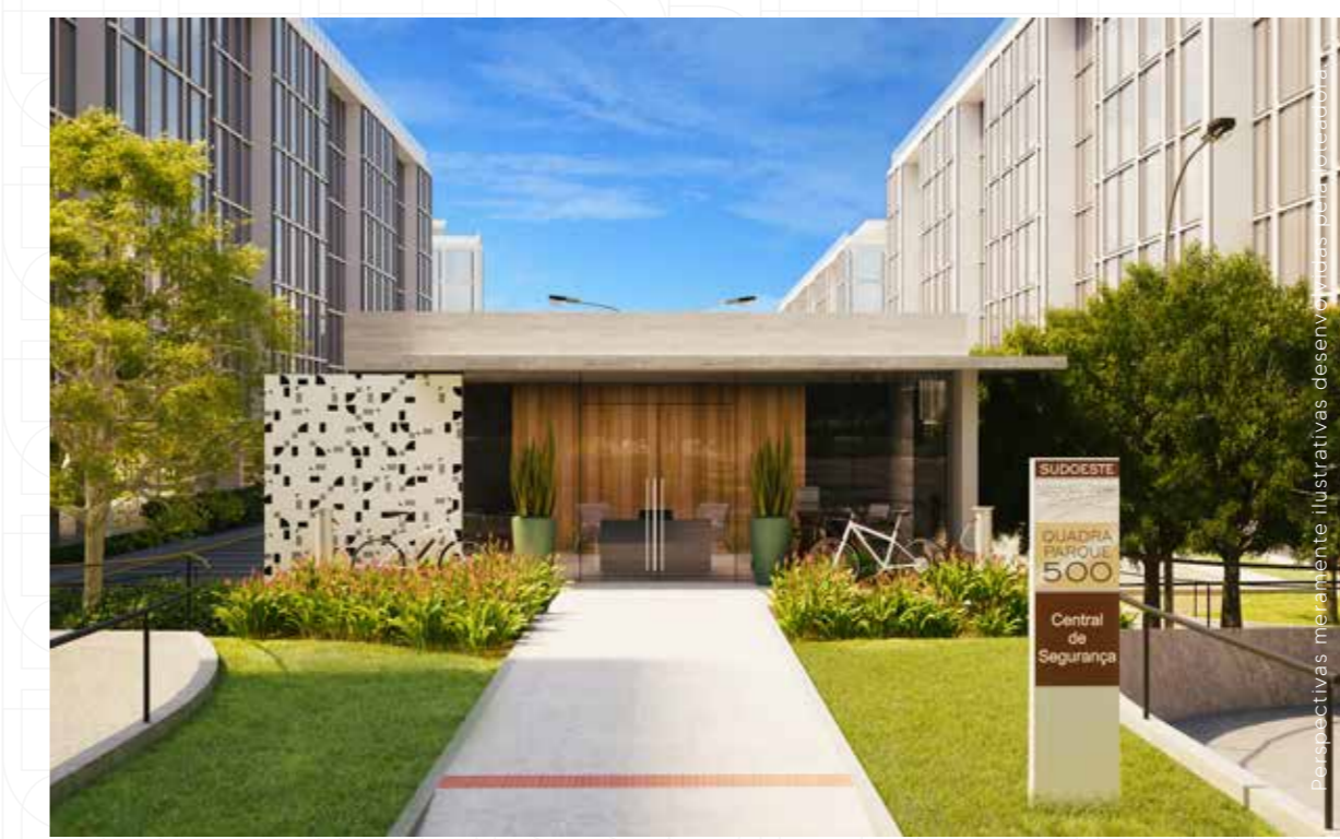
CENTRAL DE MONITORAMENTO
